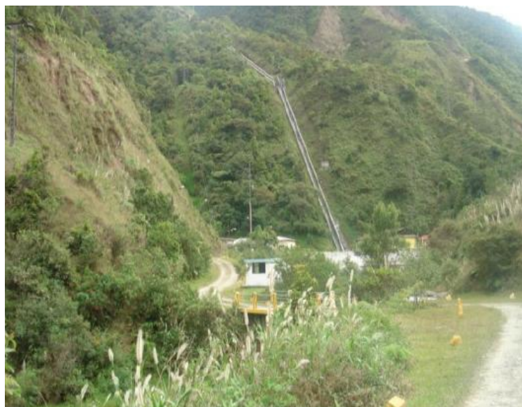
Ilustración 46. Hidroeléctrica Ing. Carlos Mora Carrión en la Parroquia Sabanilla
